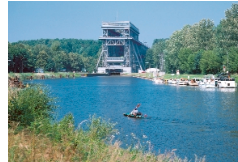
Oder-Havel-Kanal, Schiffshebewerk Niederfinow
